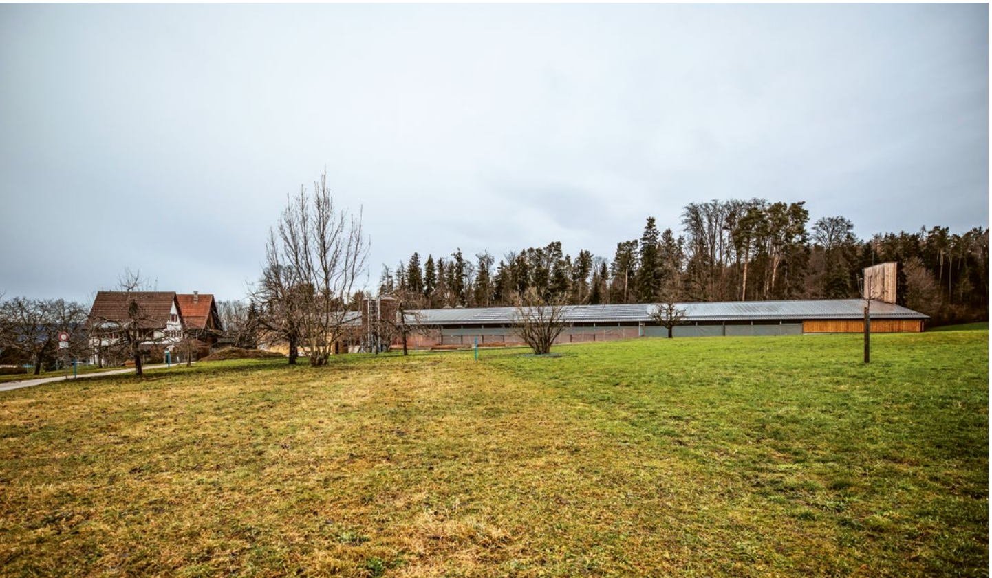
Berghof, Erlenbach: Schätzung des neu erstellten Oekonomiegebäudes (Hühnerstall) bei der Familie Wydler
