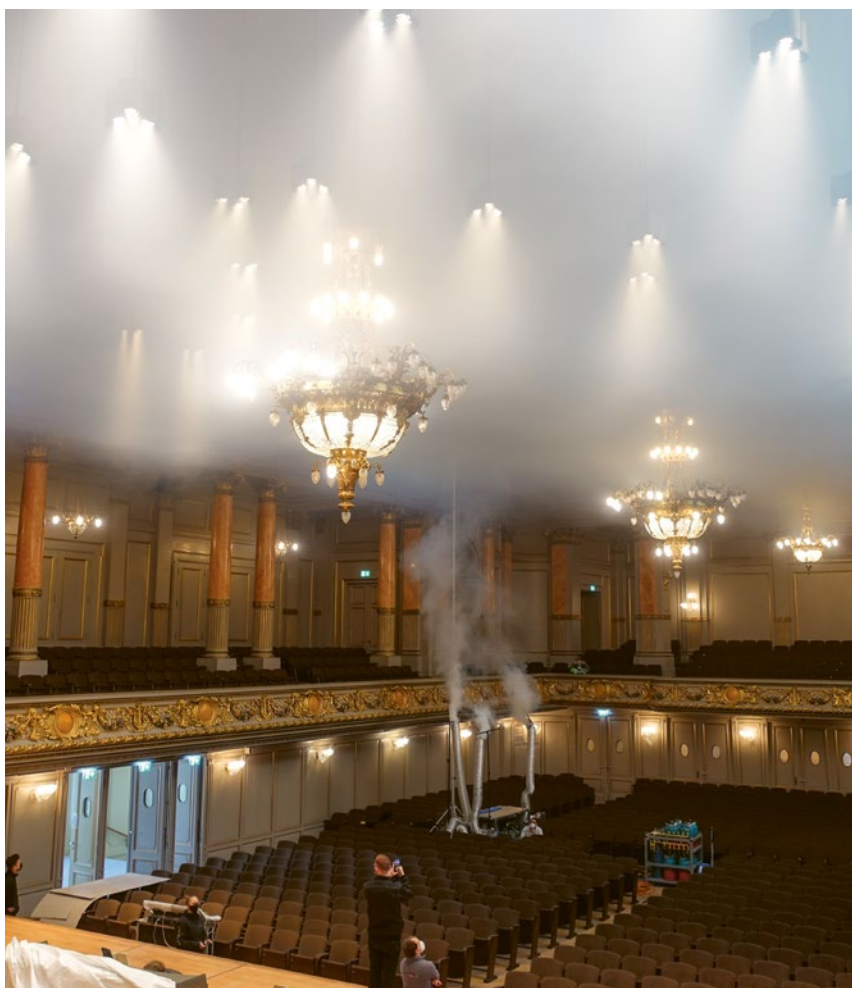
Der Warmrauchversuch in der grossen Tonhalle Zürich zeigt die einwandfreie Funktion der Maschinellen Rauch- und Wärmeabzugsanlage
