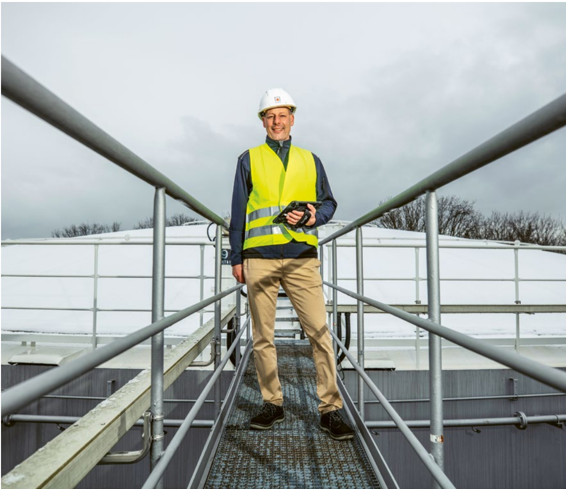
Auf den Tanksilos überprüft Andreas Buchmann, Brandschutzexperte, die Funktionstüchtigkeit der Berieselungsanlagen
