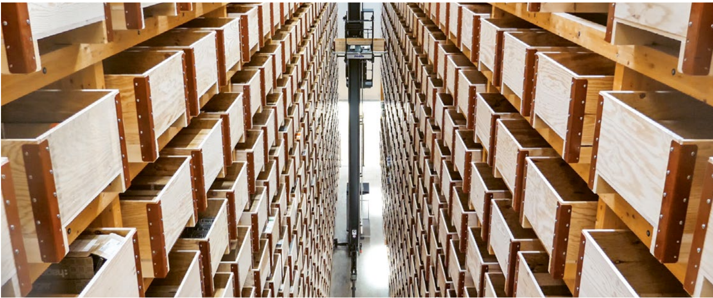
Das 22 Meter hohe Hochregallager bei Sonepar Suisse, Wallisellen, wurde auf 1'500 m 2 in einer Holzkonstruktion erstellt
